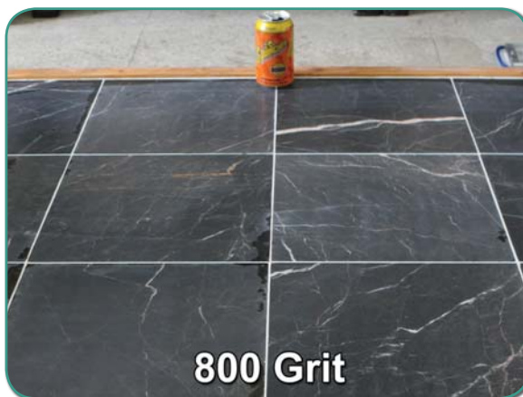
Рисунок 4-C: Состояние пола после обработки светло-желтыми алмазными пластинами (800 Grit).
