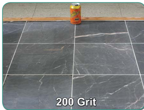
Рисунок 4-A: Состояние пола после обработки коричневыми алмазными пластинами (200 Grit).
