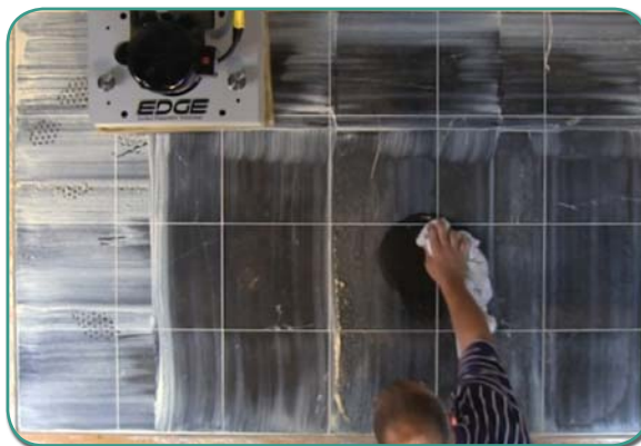
Рисунок 6-А: Для того, чтобы проверить результат работы - протрите небольшой участок пола чистой влажной тканью. Если блеск пола Вас не устраивает - сделайте еще два прохода.
