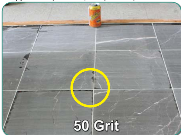
Рисунок 2-C: Пол после обработки пластинами 50 Grit. Обратите внимание, что неровность стала менее заметной.
