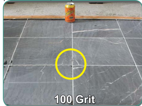
Рисунок 2-D: Пол после обработки пластинами 100 Grit. Неровность в жёлтом кружке стала еще менее заметной.
