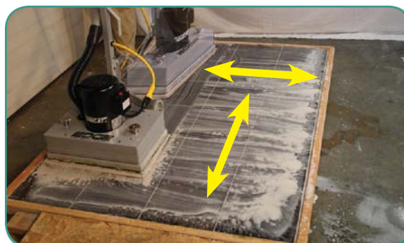
Рисунок 5-С: При работе всегда двигайтесь только вперед или назад. Никогда не перемещайте машину в боковую сторону.
