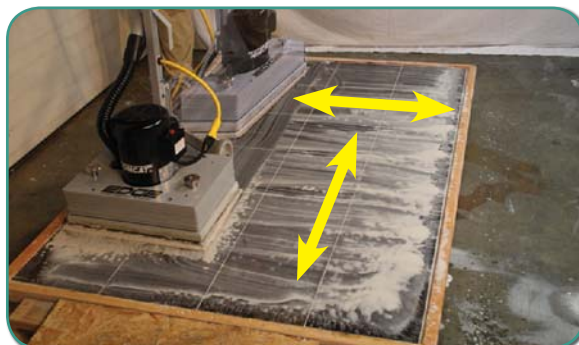
Рисунок 3-Д: При работе всегда двигайтесь только вперед или назад. Никогда не перемещайте машину в боковую сторону.
