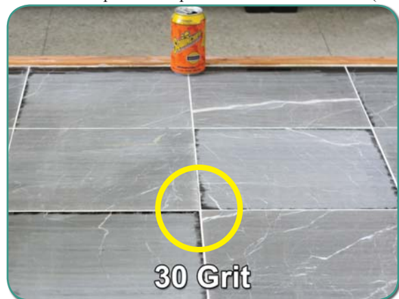
Рисунок 2-B Пол после обработки пластинами 30 Grit. В жёлтом кружке - неровность, которая теперь стала заметной.
